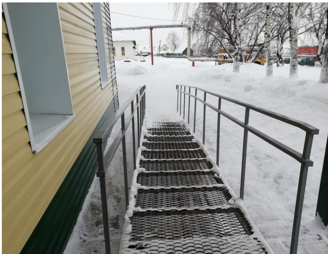
Рис. 2. Установлен пандус со стороны центрального входа в ОО
